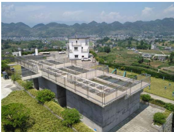
重庆市巫溪县羊桥坝水厂净水池
