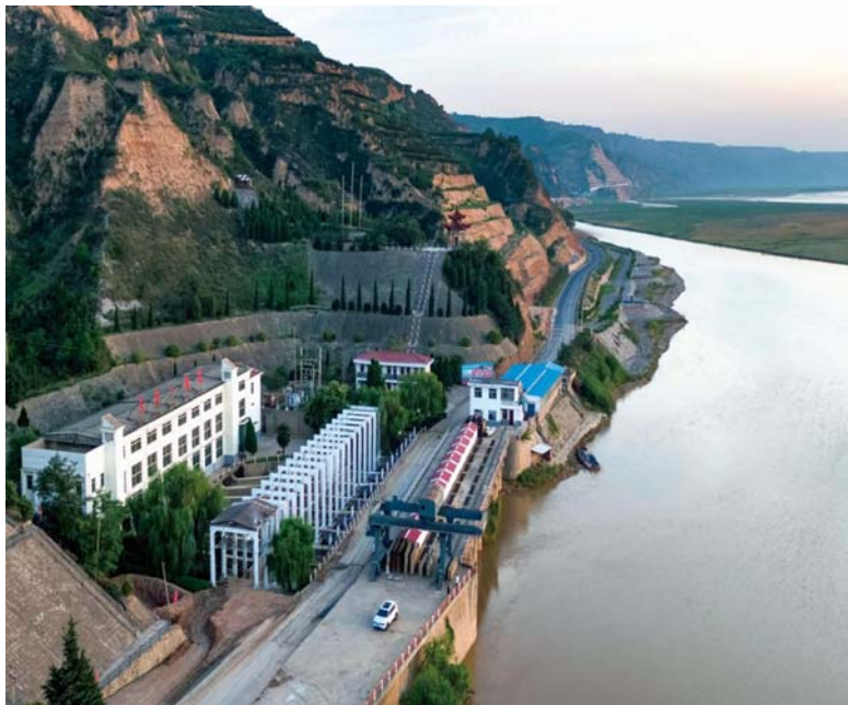
陕西省东雷抽黄工程东雷一级站
