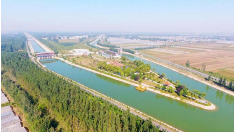
山东省位山灌区二、三千渠渠首
