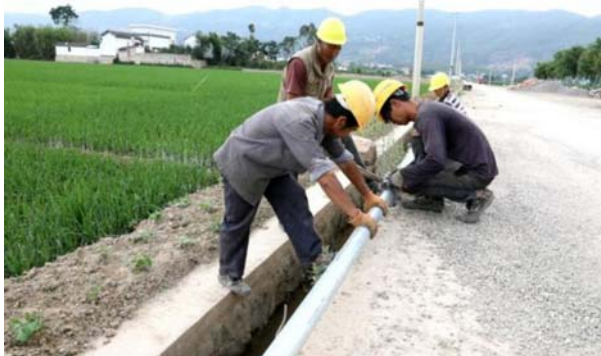
云南保山市施甸县供水工程问题整改现场
