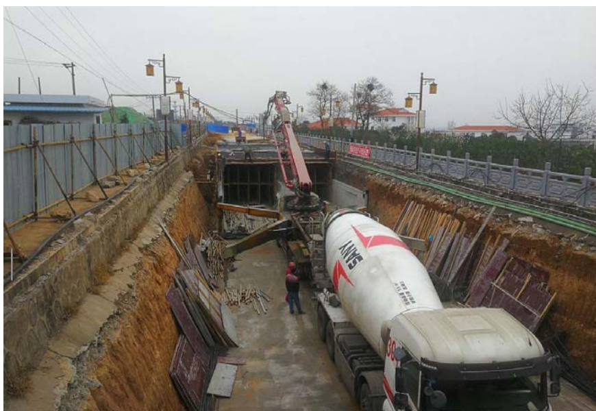
陕西石门灌区东干渠节水改造工程渠道衬砌施工现场
