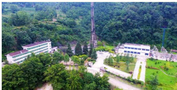
2019年农村水电安全生产标准化 一级电站陕西卧龙台电站
