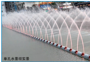
单孔水景观坝实景
