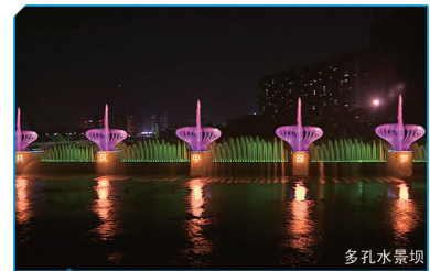
多孔水景观坝
